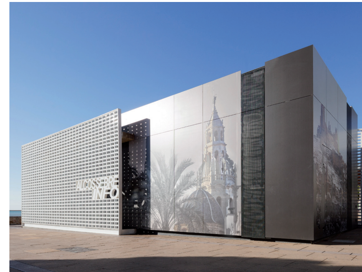
Proyecto / Project: Oficina de Turismo / Tourist information office Ubicación / Location: Alcoobre, España / Alcoobre, Spain Estudio / Studio: Sanahuja&Partners
